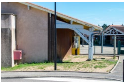
◀ Parking de l'école de la Chatelaise
